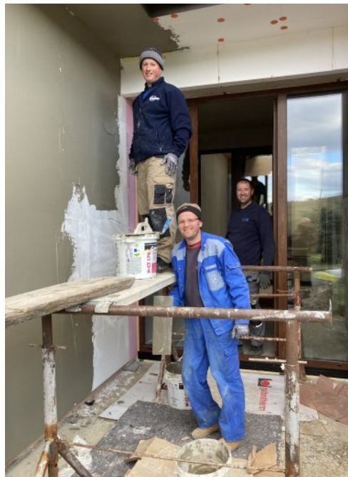
23. októbra sa dokončilo zateplenie fasády nového refektára.
