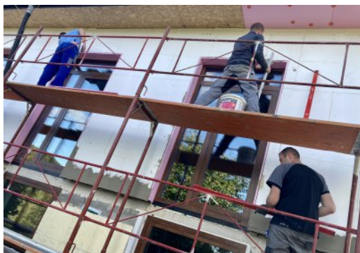
1. októbra zateplovali brigádnic z Vavrečky fasádu nového refektára.
